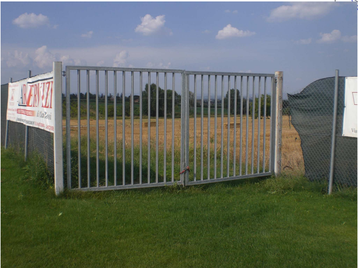
Ingresso mezzo di soccorso
